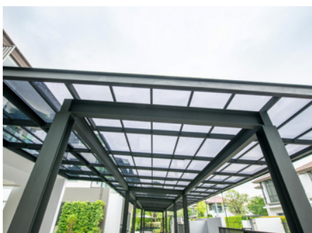
Mái sảnh, mái nhà để xe
