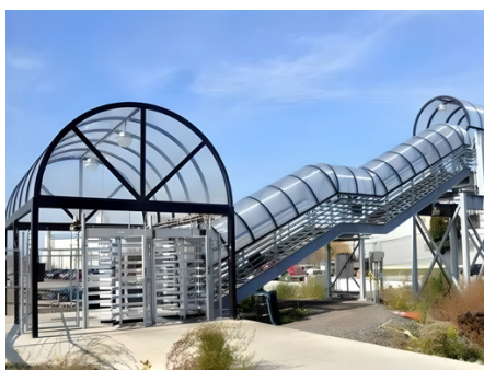
Mái che cầu vượt đi bộ
