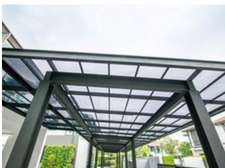
Mái sảnh, mái nhà để xe
